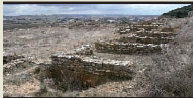
Antigua presa romana. Cascante ❖
